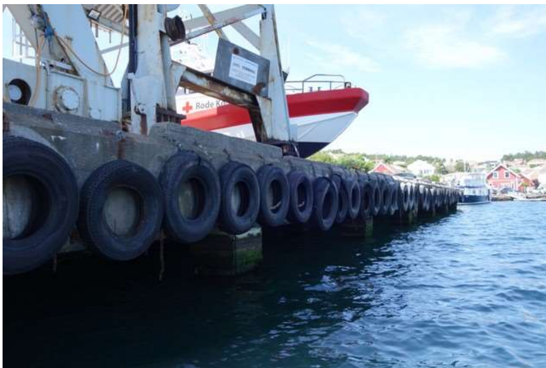
Bilde 15: Fenderverk/fronbjelke
