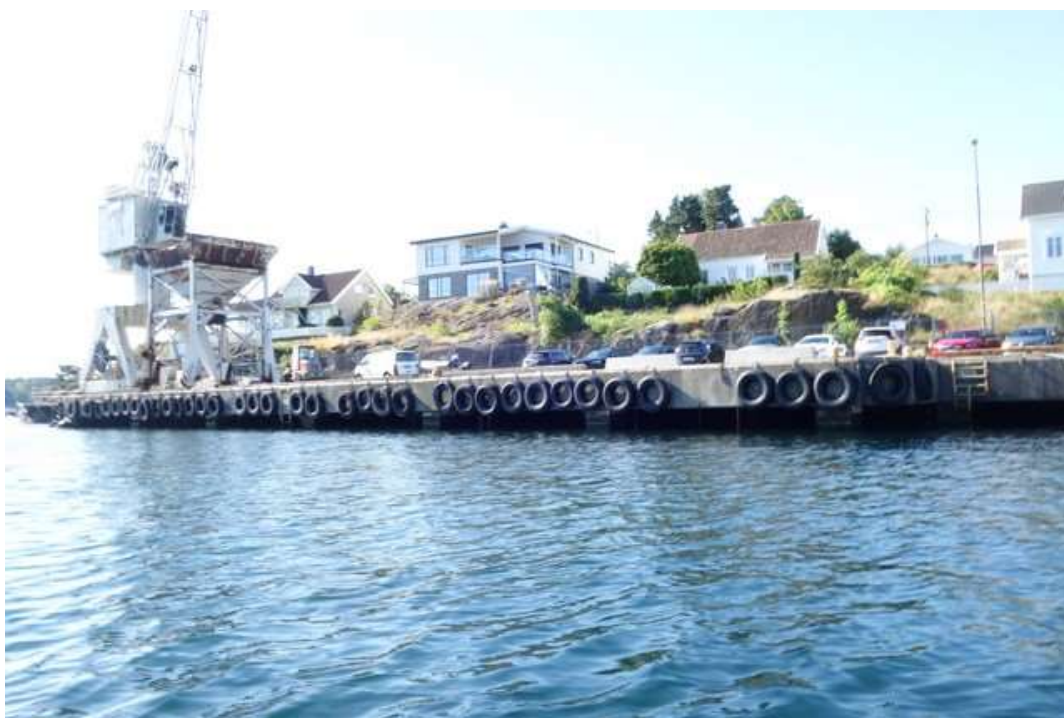
Bilde 16: Fenderverk/fronbjelke
